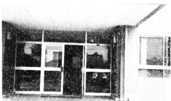
西三河農業技術センター 安城分館 正面
